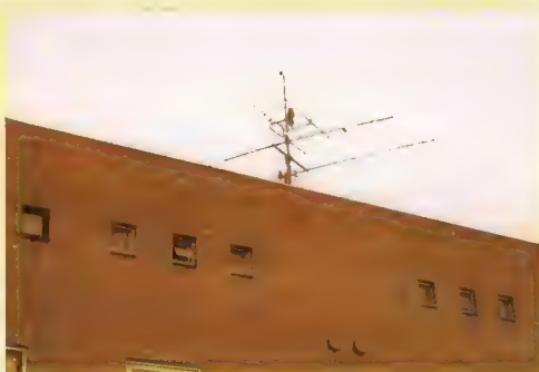
Meerdere antennes dicht bij elkaar.
